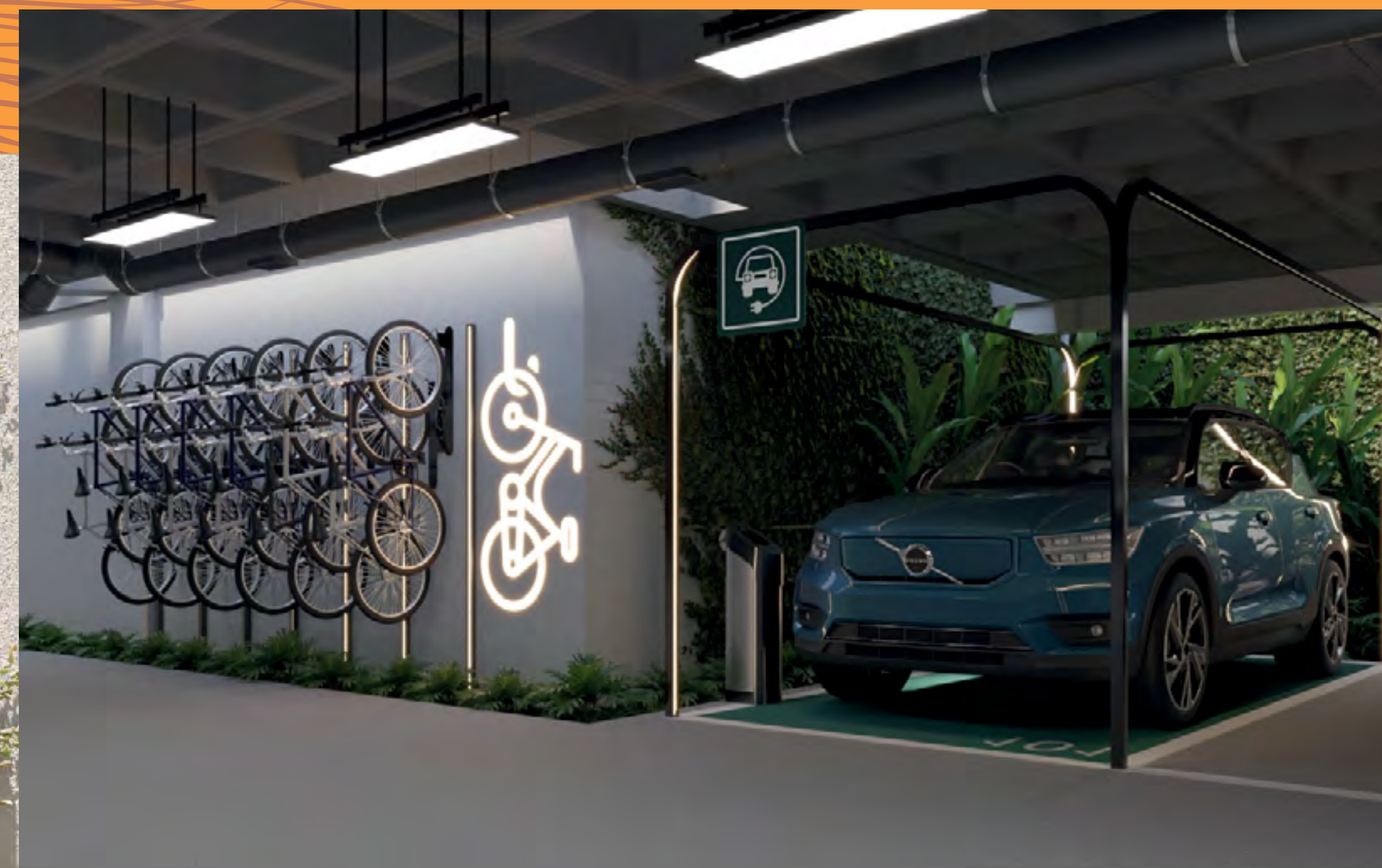
Bicicletário e Estação de Recarga
